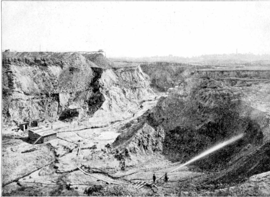
Abb. 1. Sandgewinnung im Abspritzbetrieb. Steinkohlenbergwerk Ludwigsglück I.
