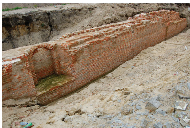
Il. 2. Widok zachodniego odcinka muru wraz z wneką strzelniczą (faza I) i filarkami (faza II) od strony miasta (fot. R. Mruczek)
