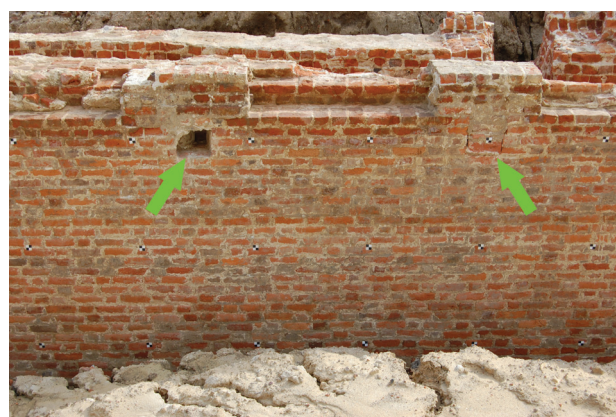
Il. 3. Filarki osadzone w otworach w miejscu wcześniejszych drewnianych stężeń (fot. R. Mruczek)
