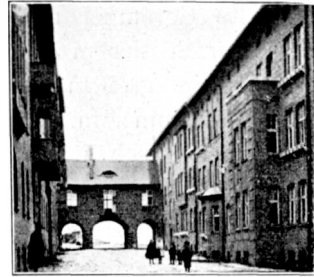
Abb. 53. Kolonie Nickischschacht. Straße zwischen zwei Wohnhäuserblocks.
