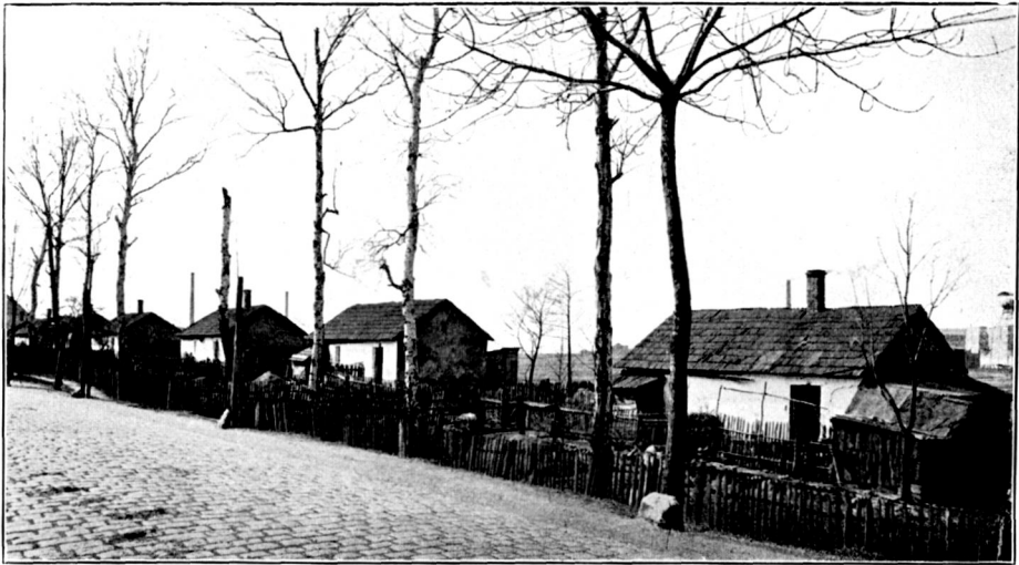
Abb. 64. Einige der sogenannten „Zwölf Apostel“. Alte Arbeiterhäuser der Hohenlohe-Werke, A.-G.
