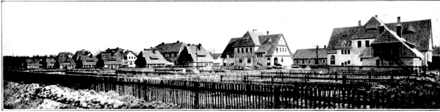
Abb. 77. Kolonie Emanuelsthal. Arbeiterhäuser in der Bahnhofstraße. Rückansicht mit Gärten und Stallgebäuden.
