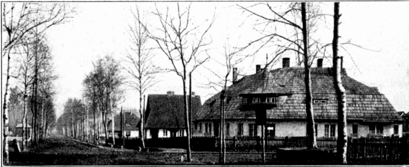
Abb. 36. Gieschewald. Beamtenhaus und Arbeiterhäuser.
