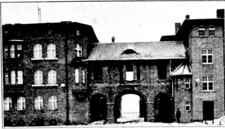
Abb. 52. Kolonie Nickischschacht. Torbogen zwischen zwei Wohnhäuserblocks.
