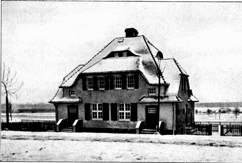
Abb. 87. Kolonie Kostuchna. Renten Häuser Nr. 2 und 3. Zwei Einfamilienhäuser (Doppelhaus).
