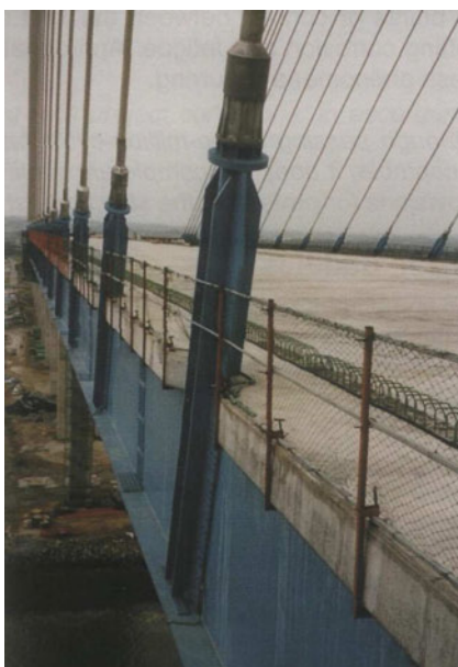
Rys.2.21. Zakotwienie sztywne w moście podwieszanym Seohae Grand, Korea
