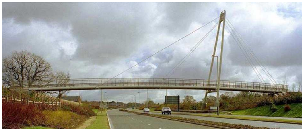
Rys.2.19. Most podwieszany Swindon, Wielka Brytania
