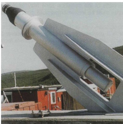
Rys.2.11. Zakotwienie sztywne w moście podwieszanym Utsjoki, Finlandia
