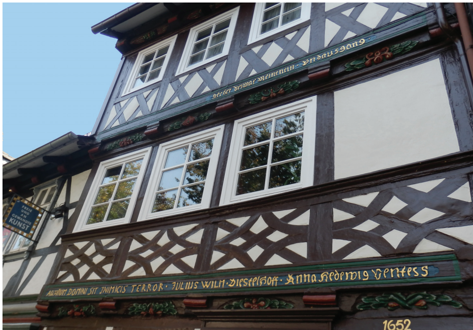
Il. 4. Goslar – dekoracyjne inskrypcje na przyciesiach ram konstrukcji szkieletowej (fot. D. Kowalska)
