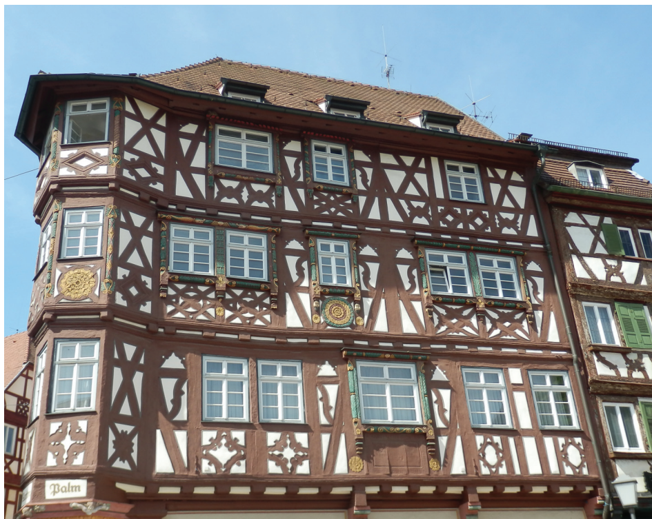
Il. 2. Palm'sche Haus w Mosbach z widocznymi „przesztynieniami” – dodawane belki były zbędne z punktu widzenia konstrukcyjnego, podnosiły jedynie dekoracyjność kratownicy (fot. D. Kowalska)
