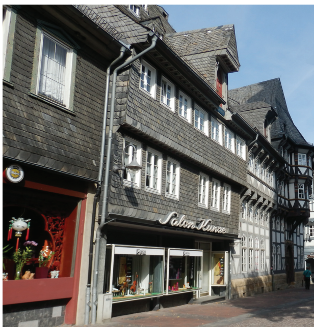
Il. 5. Goslar – lupek na elewacji maskujący drewnianą konstrukcję szkieletową (fot. D. Kowalska)
