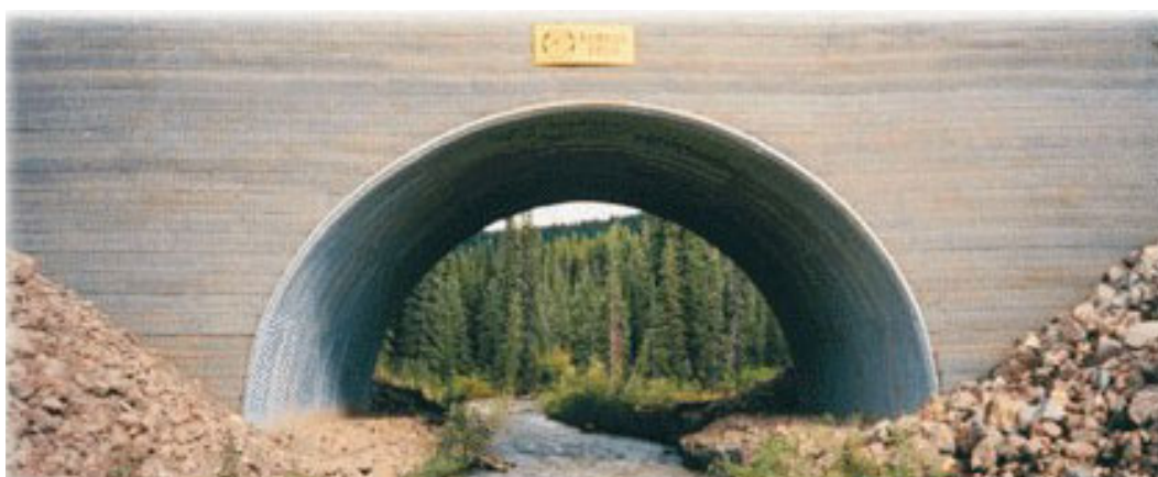
Rys. 1.1. Przepust Kemess Arch w Kanadzie o rozpiętości ponad 20 m.
