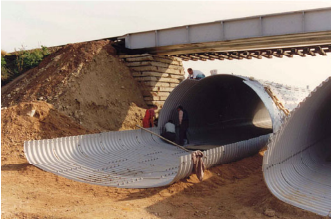
Rys. 2.24. Montaż konstrukcji przepustów.
