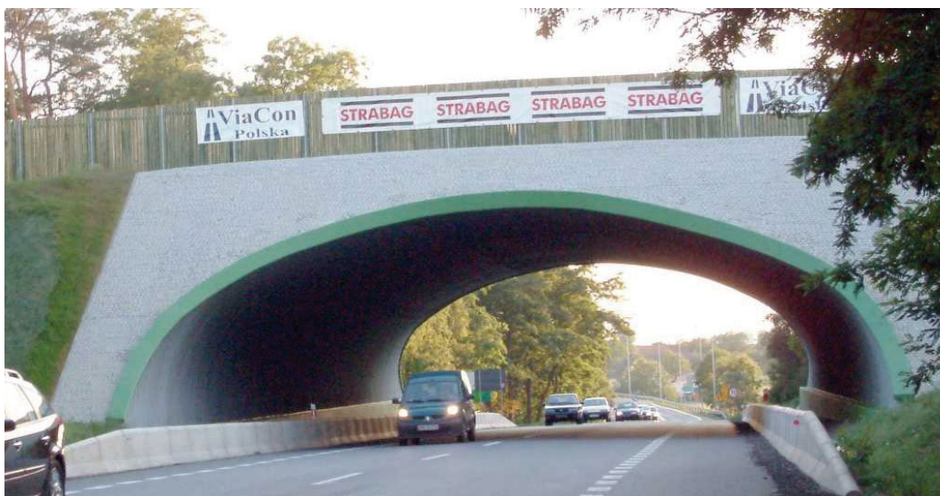
Rys. 1.2. Przepust na drodze krajowej nr 5 Wrocław-Poznań. Jeden z największych w Europie o rozpiętości ok. 17 m.
