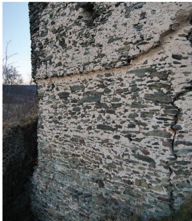
Il. 6. Bruzda po ganku bojowym widoczna w licu południowo-zachodniego boku wieży, na wysokości trzeciej kondygnacji (fot. P. Błonieński)
