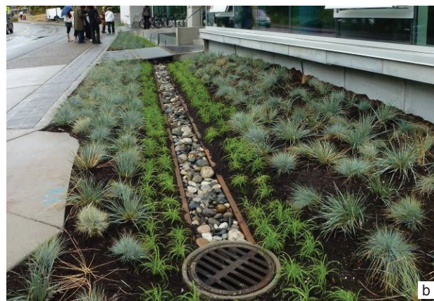
Il. 8. System gospodarki wodą: a) dach obiektu wykonany z białej folii izolacyjnej tworzący rodzaj wanny służącej do zbierania wody deszczowej, b) kanały i rowy, które w naturalny sposób rozprowadzają oczyszczoną wodę na działce Fig. 8. The water management system: a) a roof made of white insulation foil forming a sort of bathtub for collecting rainwater, b) canals and ditches which distribute purified water in a natural way
