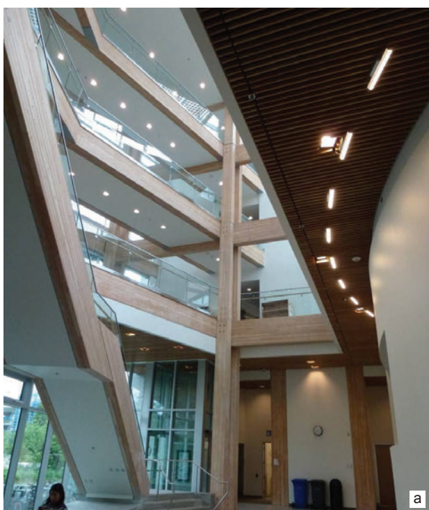
Il. 9. Wnętrza: a) widoczna drewniana konstrukcja holu i klatki schodowej, b) detal łączenia drewna umożliwiający łatwą rozbiórkę budynku Fig. 9. Interiors: a) wooden construction of the hall and staircase, b) detail of joining wood that facilitates easy dismantling of the building
