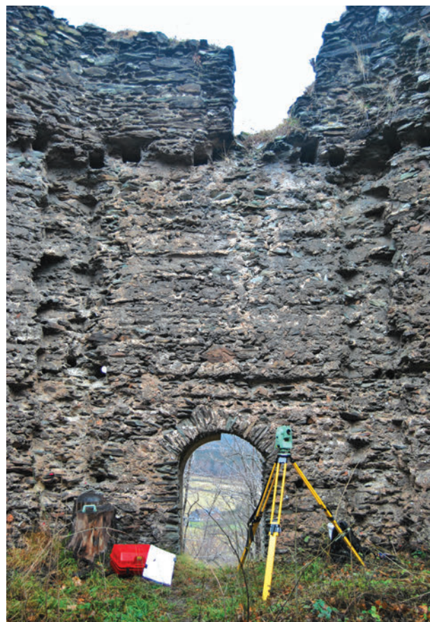
Il. 9. Wnętrze wieży ośmiobocznej w widoku na ścianę północną. Na powierzchni ścian czytelne negatywy bali oblicowania ciepłej izby; powyżej negatywy gniazd belek stropowych (fot. P. Błoniowski)
