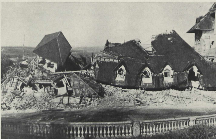
Bild 7. Völliger Zusammenbruch infolge übermäßig schweren Daches. Aufnahme eines ausländischen Ministeriums
