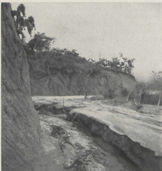
Bild 5. Straße Lubango-Mossamedes im Chellagebirge (südliches Angola). Schwere Schäden der Straßendecke infolge starker Regenfälle
