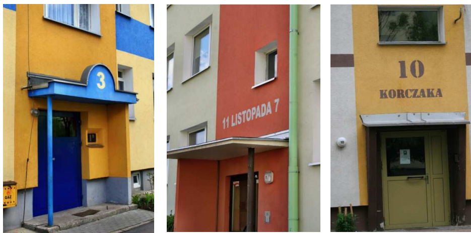
Fot. 19-21. Informacja wizualna nad wejściem do klatek schodowych bloków, Osiedle Nysa-Południe, Osiedle KEN
