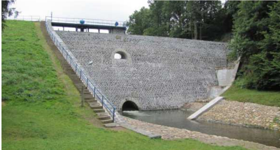
Fot. 9. Widok zapory na Złotym Potoku Pic. 9. View of the dam Złoty Potok Źródło: Praca własna / Source: Own work
