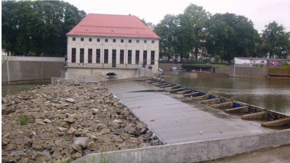
Fot. 3. Elektrownia wodna na rzece Nysie Kłodzkiej w obrębie miasta Nysy Pic. 3. Hydroelectric power station on Nysa Kłodzka river within the city of Nysa Źródło: Praca własna / Source: Own work
