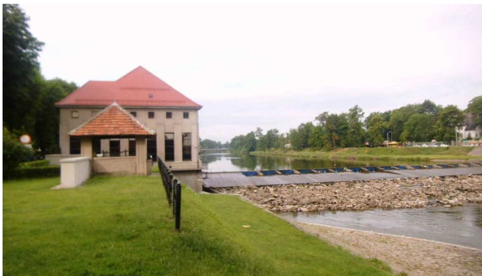
Fot. 4. Elektrownia wodna na rzece Nysie Kłodzkiej w obrębie miasta Nysy. Widok w górę rzeki Pic. 4. Hydroelectric power station on Nysa Kłodzka river within the city of Nysa. View up the river Źródło: Praca własna / Source: Own work
