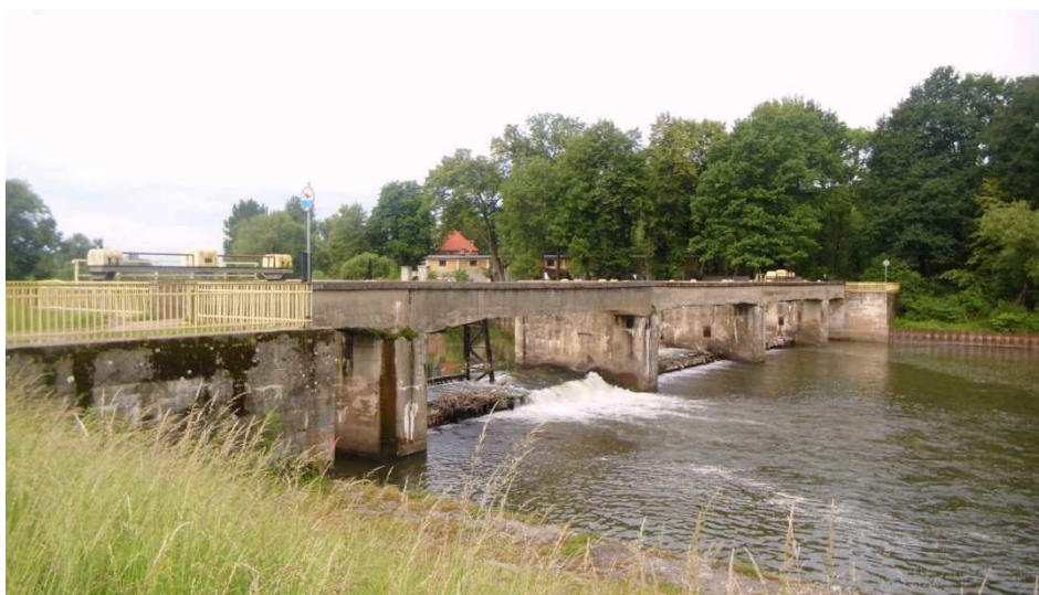
Fot. 5. Spiętrzenie wody na rzece Nysie Kłodzkiej
