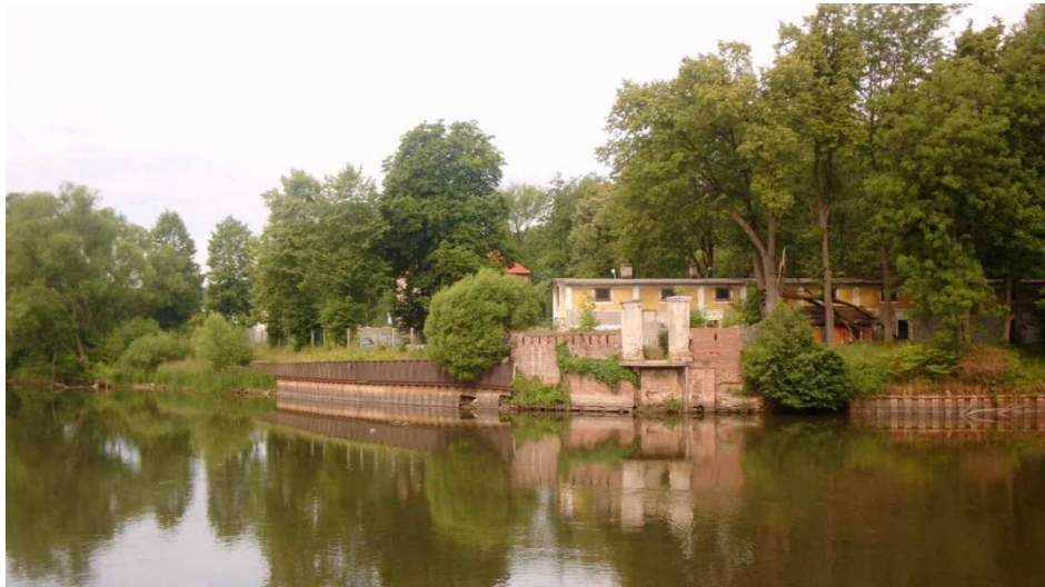
Fot. 6. Umocnienie brzegu rzeki po lewej stronie progu wodnego Pic. 6. Strengthening on the left side of threshold of water Źródło: Praca własna / Source: Own work
