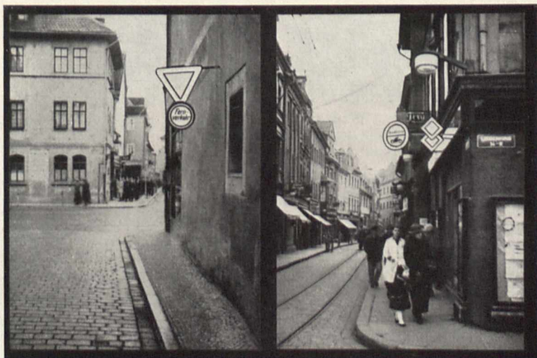
Bild 5 (oben). Kurventarnung im Scheinwerferkegel: links, bei Tage, ist die Kurve deutlich erkennbar; rechts, bei Nacht im Scheinwerferlicht, kann durch die links hell aufleuchtenden drei Bäume und die Mauer leicht der Eindruck einer Fluchtlinie erweckt werden. Die Kurve tarnt sich dann
