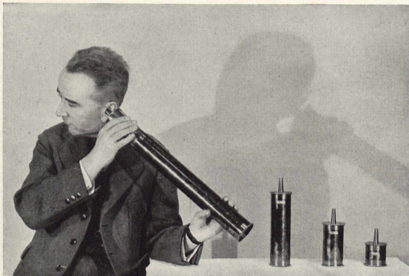
Bild 2. Röhrenförmige Resonatoren, deren Luftinhalt durch eine Verschiebung — ähnlich wie bei Fernrohren — sich vergrößern und verkleinern läßt. Sie wurden zum ersten Male von Rudolph König gebaut und 1862 auf der Weltausstellung zu London gezeigt. Obige 4 Resonatoren reichen von A (109 d. Schw.) bis c^3 (1035 d. Schw.), d. h. über 3 Oktaven; innerhalb dieses Umfangs sind 40 Halbtöne der temperierten Skala, wofür also 40 (!) Kugelresonatoren nötig wären, denn jeder Kugelresonator ist nur auf einen Grundton gestimmt
