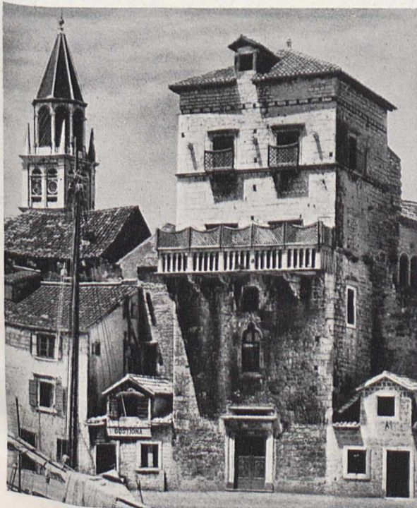
Bild 4. Beispiel für bewußte Maßstabsteigerung. Die beiden winzigen Häuschen machen das zwischen ihnen stehende nur 4—5geschossige Haus in der Wirkung geradezu zu einem Hochhaus (Trau, Jugoslawien)
