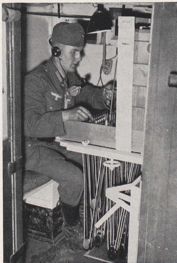
Bild 2. Vermittlungsraum mit Klappenschrank eines deutschen Fernsprechbetriebstruppwagens
