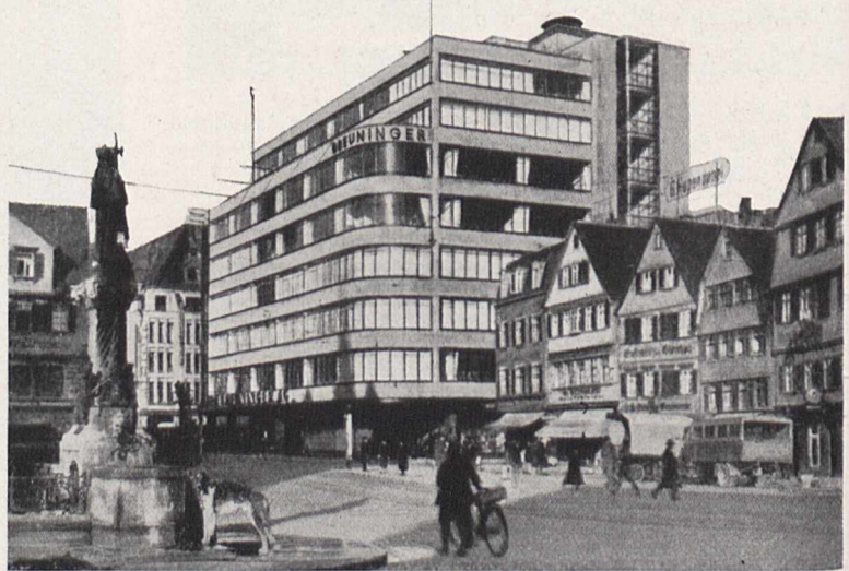
Bild 7. Rohrer Eingriff in das maßstäblich einheitliche Gefüge einer alten Platzwandung
