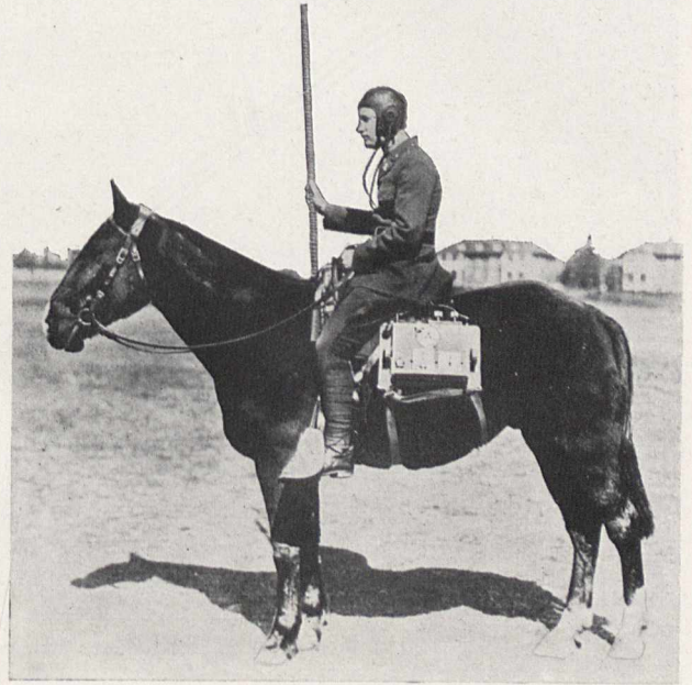
Bild 5. Amerikanischer Kavallerieoffizier mit einer drahtlosen Station. Der mit Kupferdraht umwickelte Stab bildet die Antenne. — Weit vorgeschobene Kavallerie-Abteilungen können so schnellstens die Befehle des Stabes erhalten
