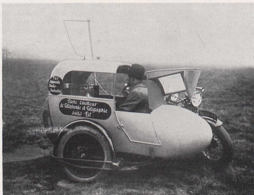
Bild 7. Motorrad mit Beiwagen des französischen Heeres, ausgerüstet mit Telephon- und Telegraphenanlage
