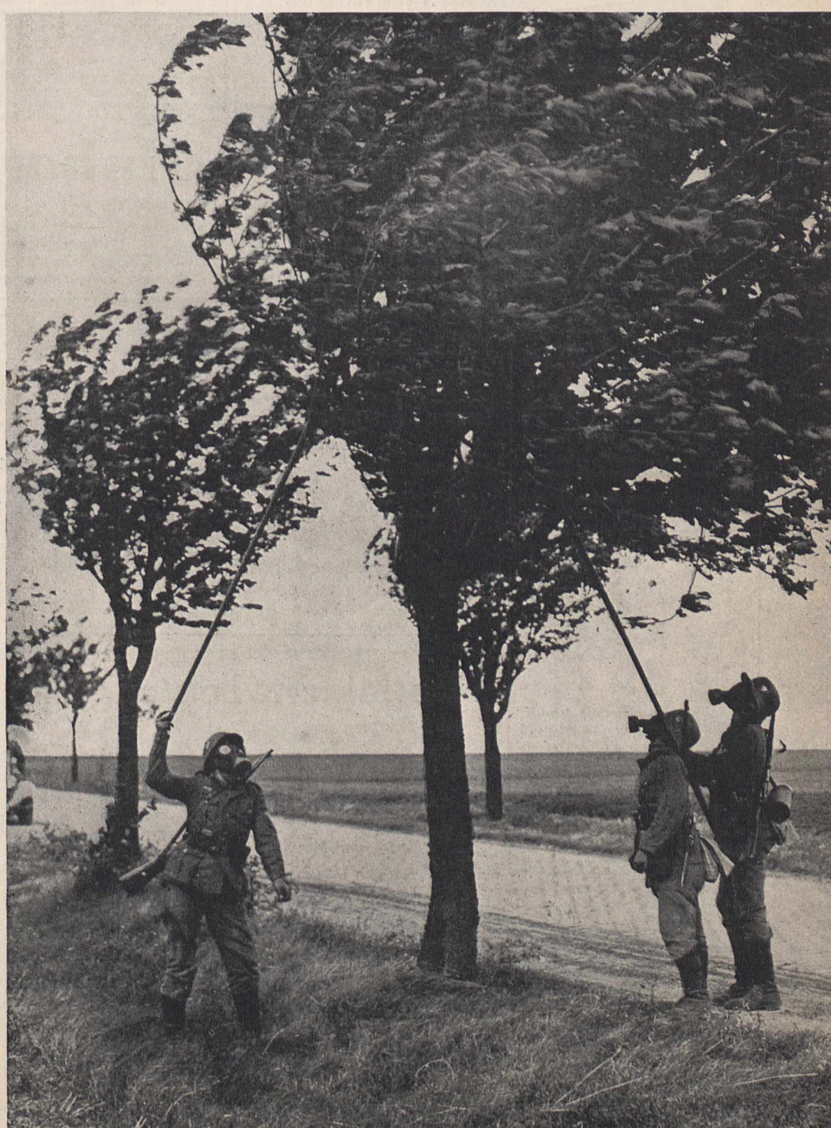
Legen einer Feldkabelleitung über Landstraßenbäume
