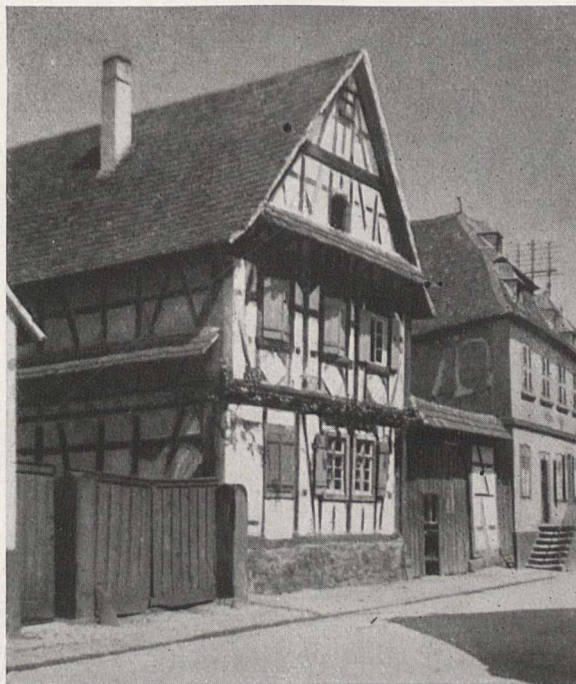
Bild 7. Aus Sparsamkeitsgründen unterbleibt in späterer Zeit vielfach die Ueberdachung. Rechts altes überdachtes links neues, nicht überdachtes Hoftor (aus Kandel)
