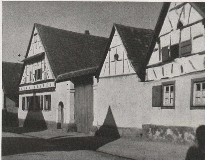
Bild 4. Aus dem Fachwerktor wird mit der Zeit das Steintor (aus Schifferstadt)
