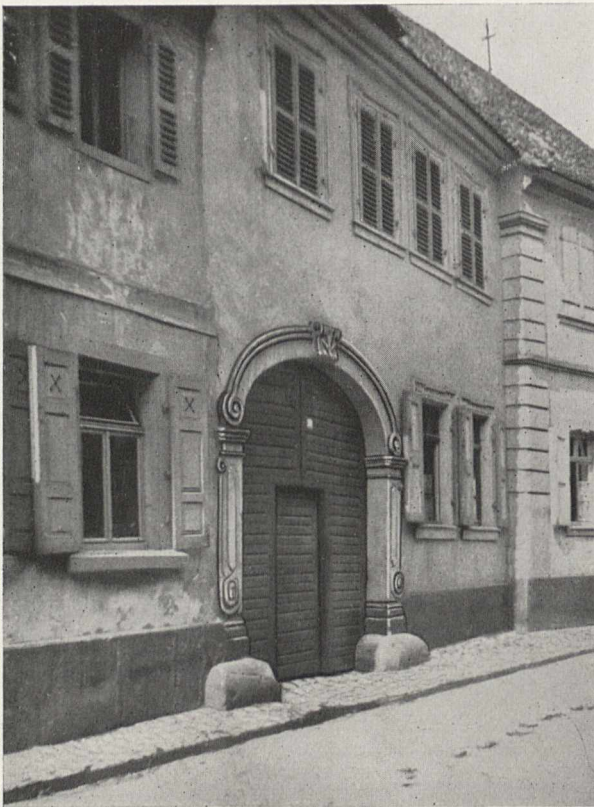
Bild 8. Bei Um- und Neubauten wurde das Hoftor ein architektonisches Glied in der Außenseite des Gebäudes (aus Freinsheim)
