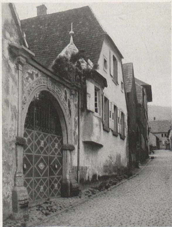
Bild 6. Der Torbogen erhält künstlerischen Schmuck. An Stelle des kleinen Daches treten Steinplatten (aus Burrweiler)
