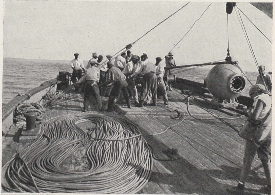
Bild 1. 800 Meter Gummischlauch für Licht- und Fernsprechröhre liegen lose an Deck. Die Tiefseekugel wird vor einer herannahenden Bö festgezurr, damit sie nicht umherrollt.
