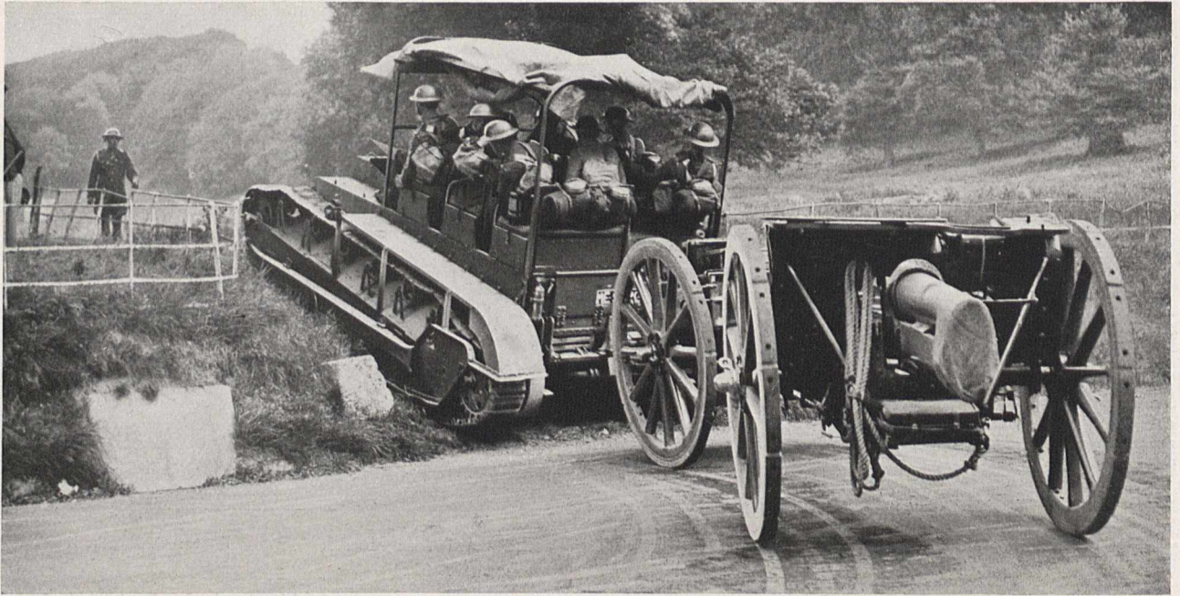
Bild 6. Raupenschlepper im englischen Manöver zieht ein Geschütz über eine Böschung
