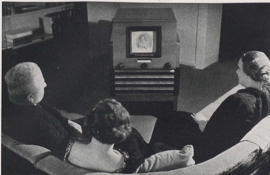
Bild 2 (links). Beim abendlichen Empfang der Berlin-Witzlebener Fernseh-Sendung mit dem Ultrakurzwellen-Empfänger. Das Gerät steht auf Rollen, so daß es überall hingefahren werden kann. Der Bildschirm ist etwas geneigt, so daß man im Sitzen oder Stehen eine gute Aufsicht hat.
