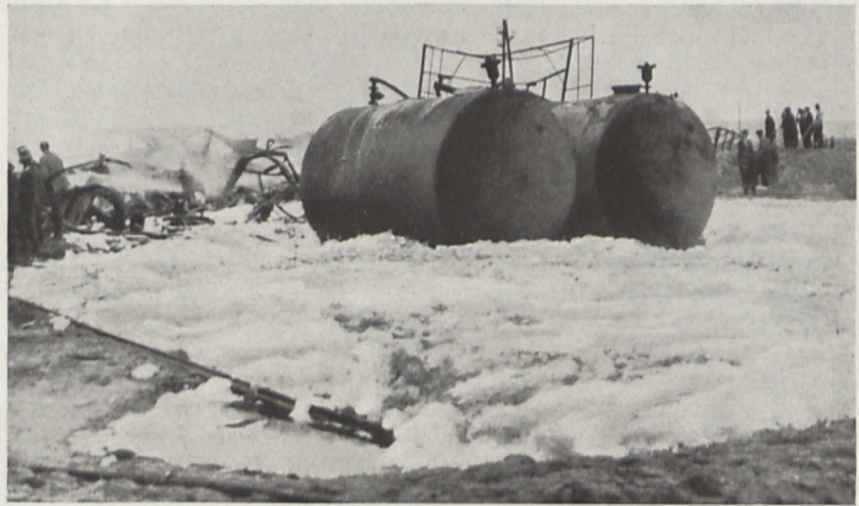
Bild 5 (oben). Die weiße Schaumdecke liegt auf einem Teil der abgelöschten Gesamtfläche mit den beiden je 28 cbm großen, zum Teil mit Oel gefüllten Kesseln in der Feuerzone
