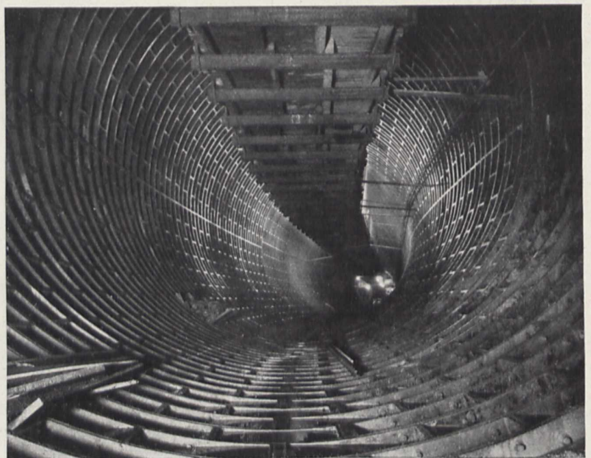
Bild 2. Baustelle des Mersey-Tunnels An der Decke hängend die Arbeitsbühne
