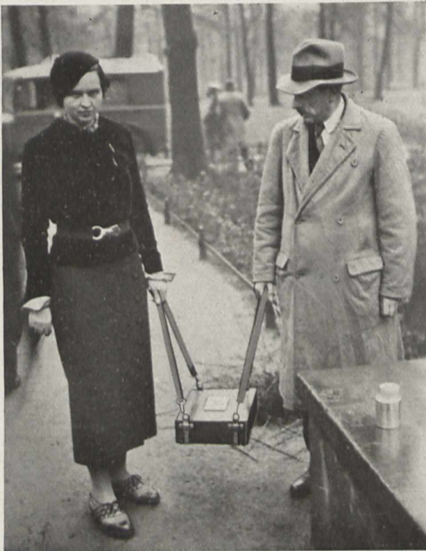
Bild 3. Mesothor-Beförderung im Schutzkasten aus Blei
