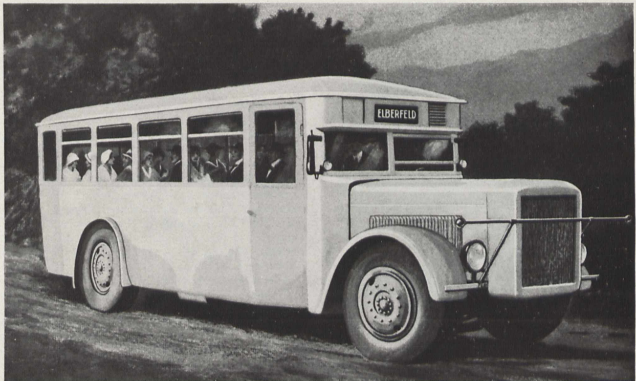
Fig. 4. Dampfauto der Schwebbahn Barmen-Elberfeld Vohwinkel A. G., der seit einem Vierteljahr im Betrieb ist und sich sehr bewährte.
