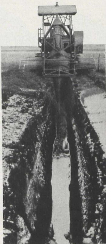
Fig. 9. Grabenziehmaschine bei der Arbeit
