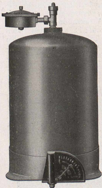
Fig. 1. Stahlflasche mit Butan. 1 kg verflüssigtes Butan erfordert nur 0,92 kg Flaschengewicht. — 1 kg Leuchtgas erfordert 12 kg Flaschengewicht.
