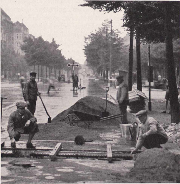
Fig. 1. Einbau der Bodenkontaktschwelle für Verkehrsregelung.
