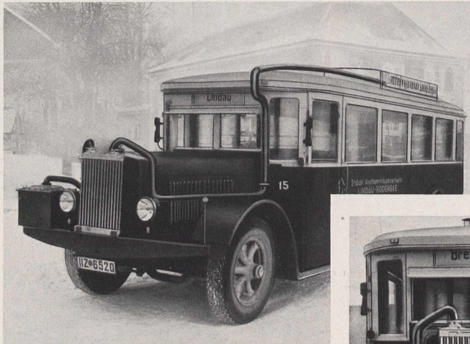
Fig. 1. Der Omnibus Lindau-Bregenz wird mit Holzgas betrieben. Die Luftkühlung des Gasmisches erfolgt durch eine Blechrohrleitung über das Wagendach.
