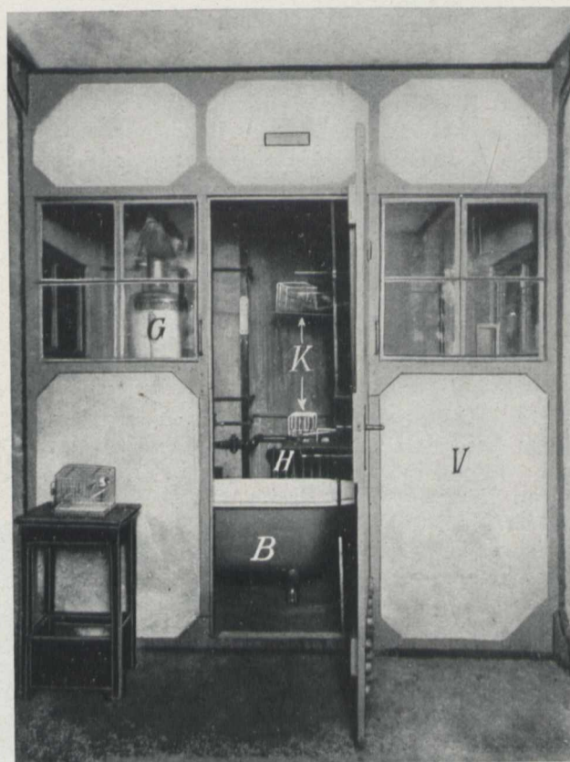
Versuchsbadezimmer für hygienische Untersuchungen an Gasbadeöfen
