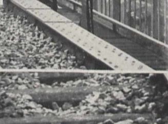
Fig. 4. Fahrsperr als Kippschiene neben dem Gleis in Verbindung mit einem Lichttagessignal
