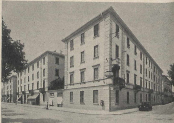
Fig. 5. Laubengang-Wohnungen in Mailand, Straßenseite
