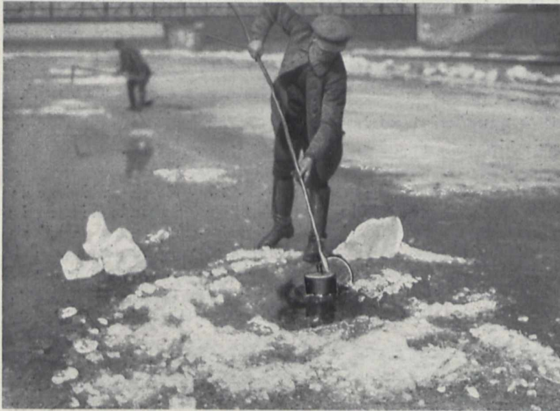
Fig. 3. Einbringen von Sprengmunition unter die Eisdecke
