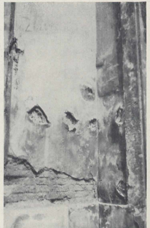
Fig. 7. Aufgeplatzte Blasen (Verwitterungskrater) in wenig durchlässiger Verputzschicht
