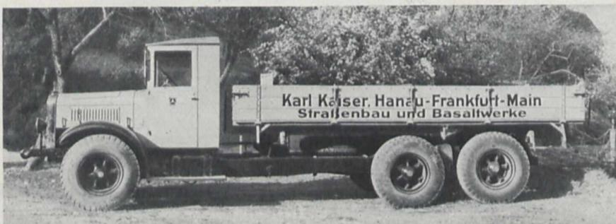
Fig. 2. Dreiachsiger Kipplastwagen für 7 Tonne Nutzlast mit Dieselmotor (Daimler-Benz A.-G.)
