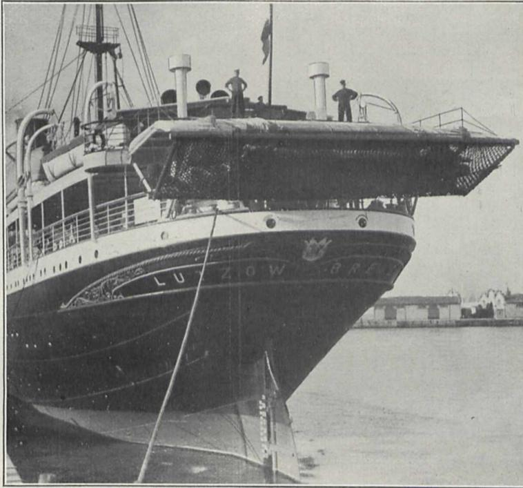
Fig. 2. Die zusammengerollte Kiwullsche Staubahn am Heck des Dampfers „Lützow“. Phot. Nordd. Lloyd, Bremen
