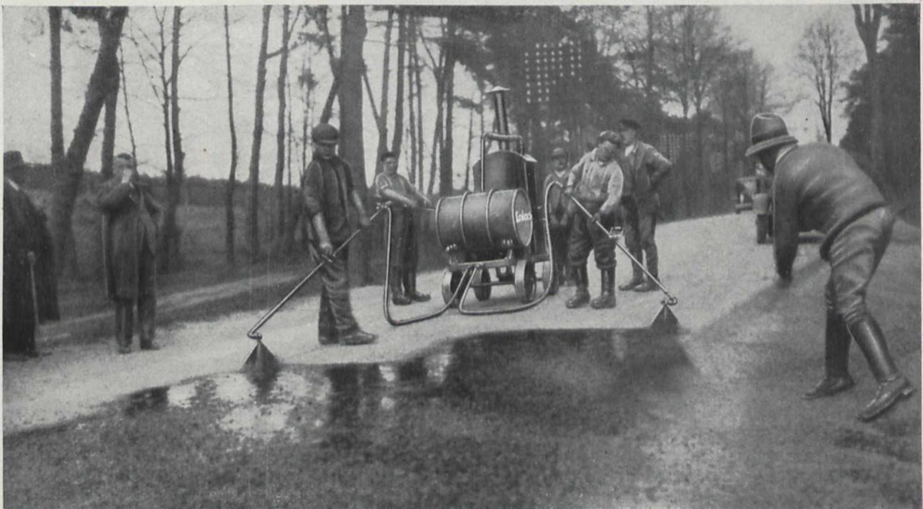
Fig. 2. Aufbringen des Kaltasphalts mittels Handsprengmaschine. Straßenbau bei Hochspeyer i. Pfalz.
