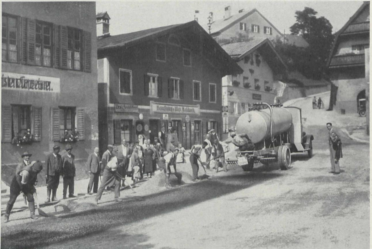
Fig. 3. Druckspritztank beim Aufspritzen von Kaltasphalt.
