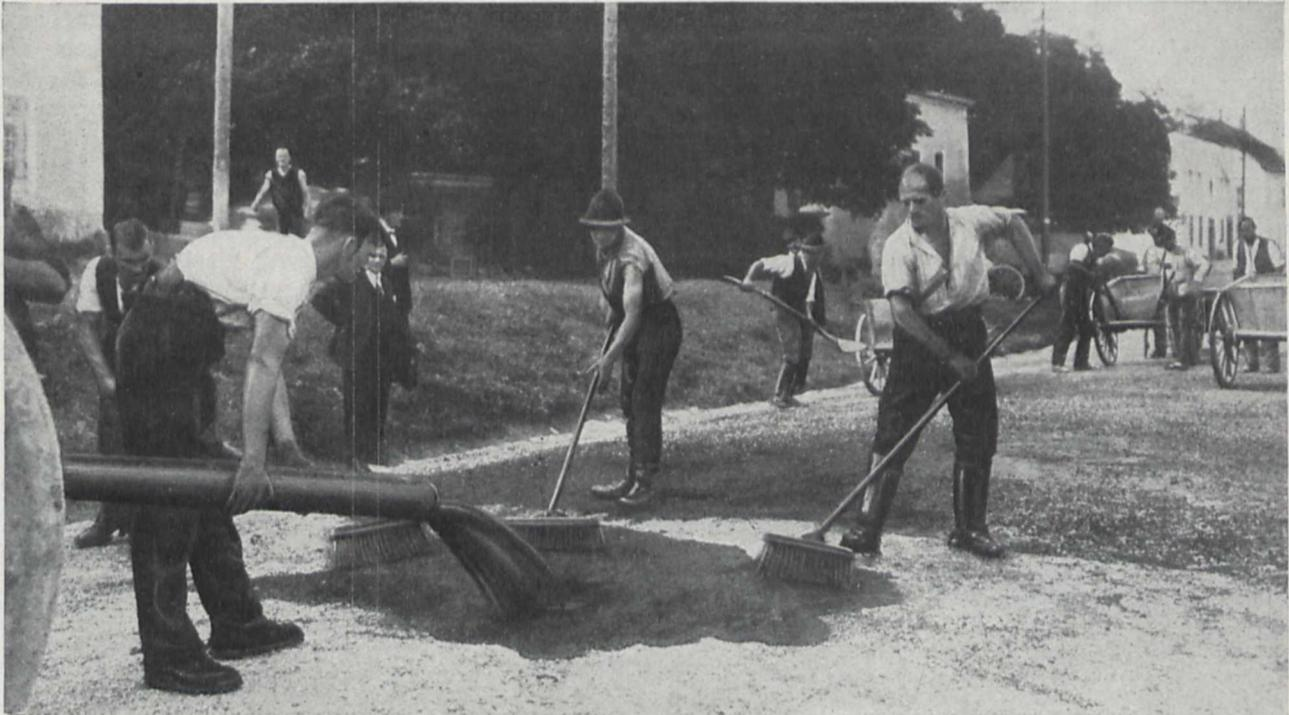
Fig. 1. Aufbringen des Kaltasphalts und Verteilen des Materials durch Besen.
