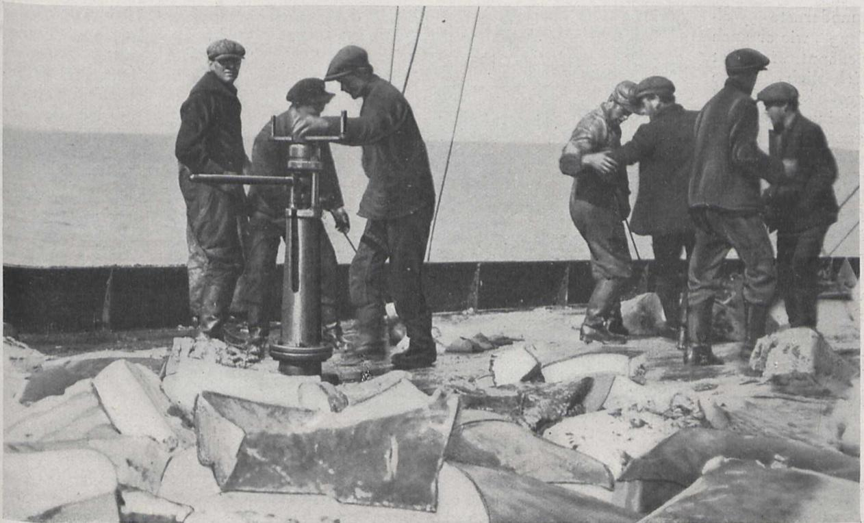
Fig. 10. Füllen der Speck-Kochapparate vom Deck aus.
