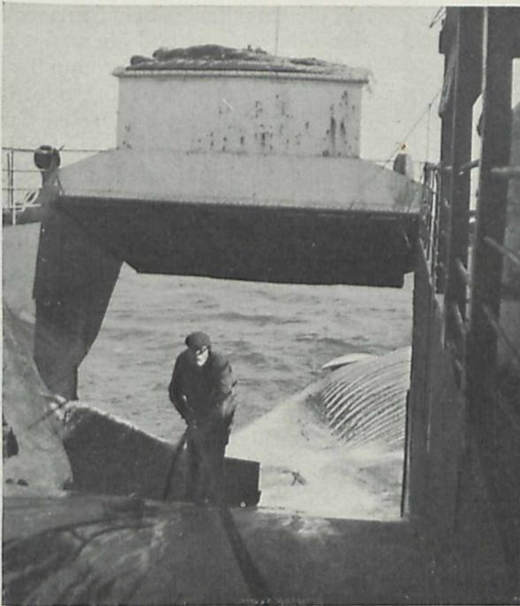
Fig. 5. Schleibbahn am Heck, auf welcher der erlegte Wal aus dem Wasser auf das Schiff gezogen wird.
