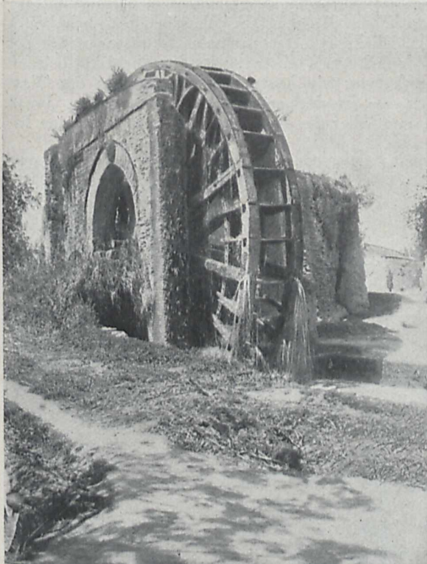
Fig. 2. Maurisches Wasserschöpfrad bei La Nora (Murcia-Huerta). Die Felgen sind hohl und heben das Wasser aus der Acequia in einen höher gelegenen Bewässerungsgraben, oben auf der Mauer.
