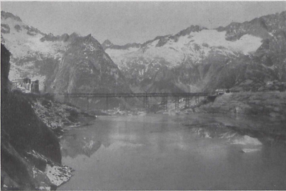
Fig. 5. Der Gelmer See mit dem Transportgerüst aus Beton für den Bau der Sperrmauer. Rechts: Unterkunfts- und Verpflegungsgebäude. Links: Endstation der Luftkabelbahn, Zementsilo, Kiessortier- und Betonieranlage.
