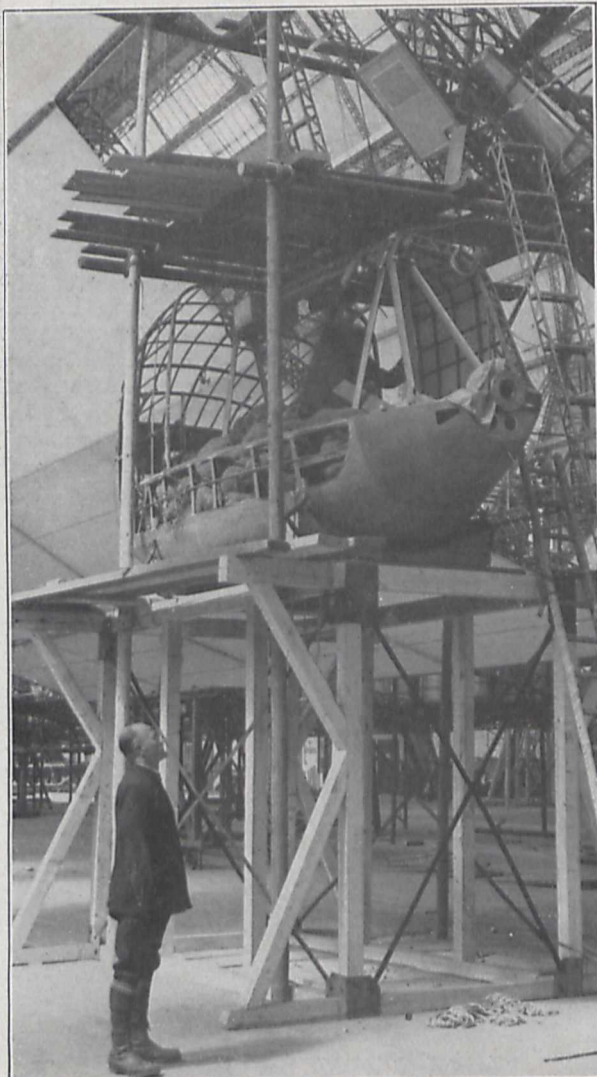
Fig. 2. Motorgondel im Bau.
