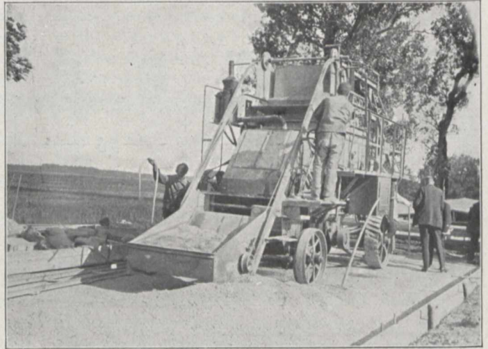
Fig. 3. Betonmischer des Sonthofener Hüttenwerks.
