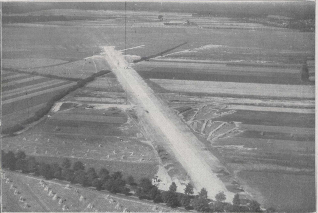
Fig. 3. Junkers Zement-Startbahn in Dessau.
