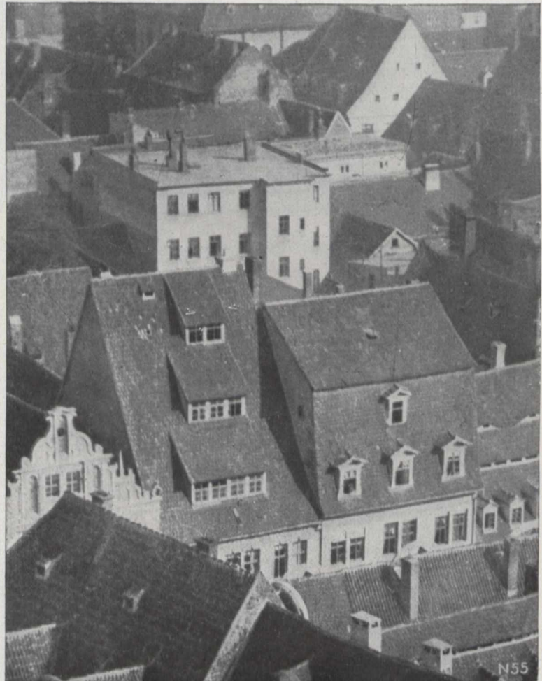
Fig. 2. Blick auf die Dächer einer Stadt. Der Bau mit flachem Dach sitzt als Fremdkörper im Stadtbild.
