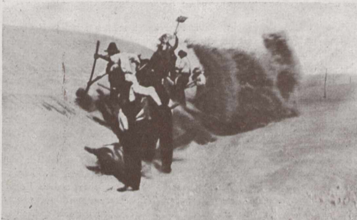
Fig. 3. Eingeborene schaufeln die Strecke während des Sandsturms frei.
