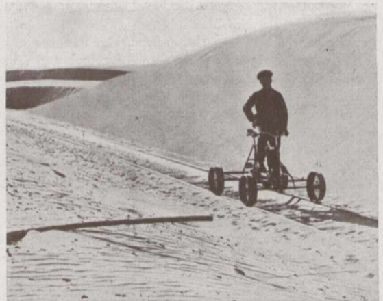
Fig. 4. Die erste Inspektionsfahrt auf der freigemachten Strecke.
