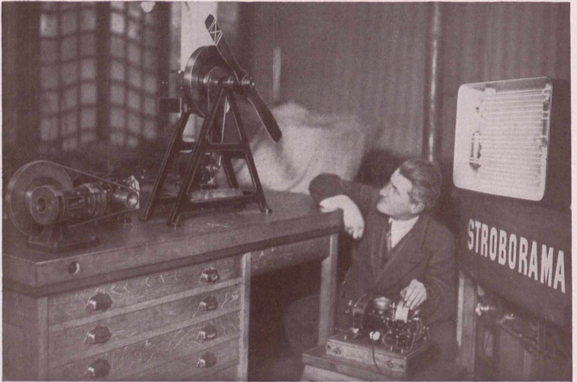
Untersuchung eines Flugzeugpropellers mit els des Stroborammas.
