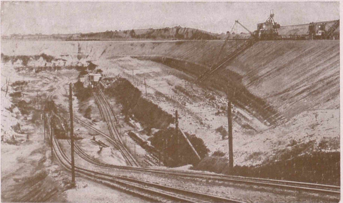
Fig. 1. Maschinelle Gewinnung von Bernstein im Tagebau durch Schrägaufzüge in Palmnicken.
