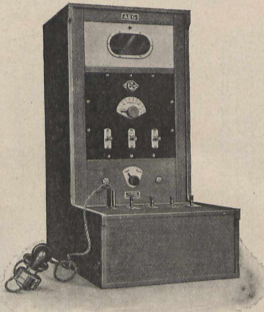
Fig. 2. AEG-Zwischenverstärkerschrank zur Gegensprechschaltung.
