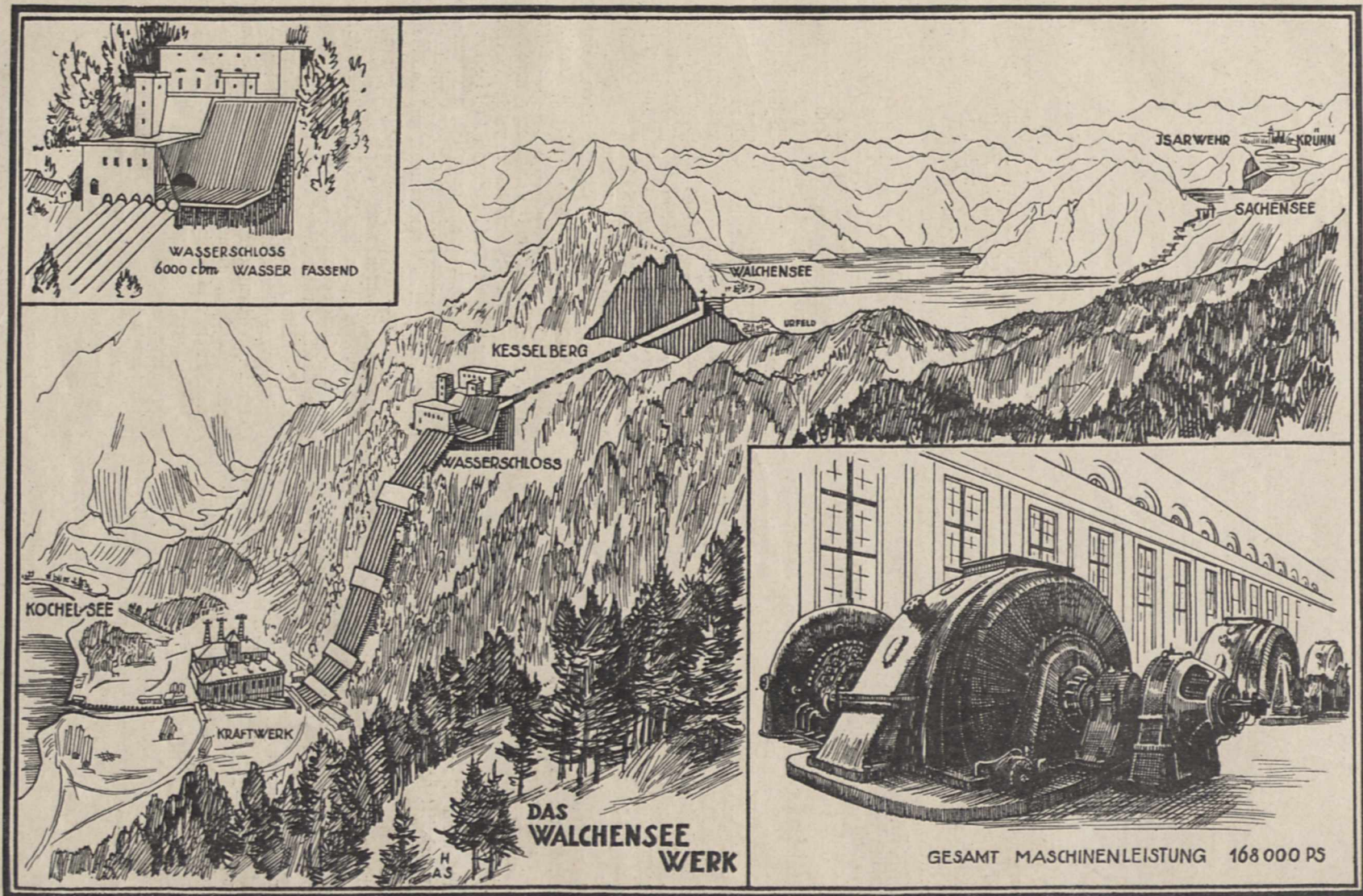
Fig. 2. Gesamtansicht des Walchenseekraftwerks und seiner Wasserversorgung (vergl. Umschau 1924, Heft 13).
