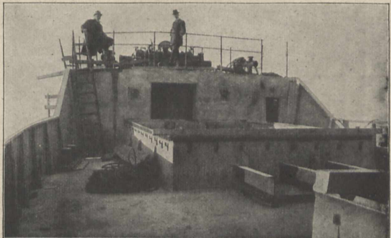
Fig. 3. Das vordere Beton-Schiff mit Hauptdeck, Ladelucken, Windenfundament, Schanzkleid und Back.
