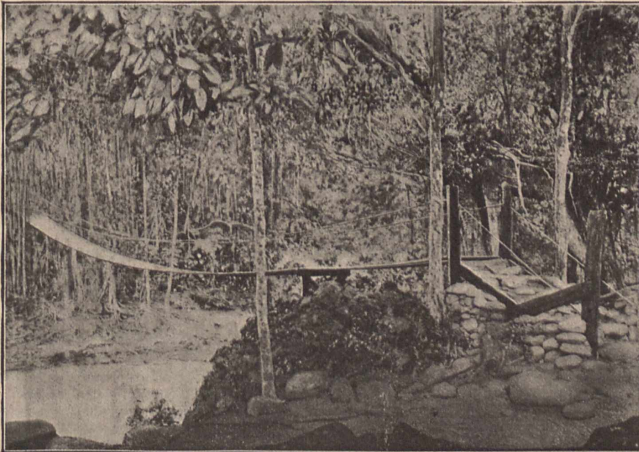
Fig. 6. Brücke von Eingeborenen auf Java errichtet. Als einziges Tragelement ist das Seil verwandt.
