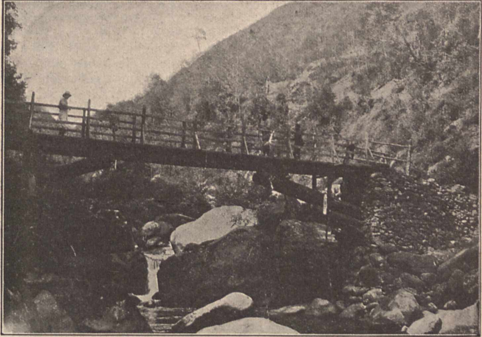
Fig. 5. Kragträgerbrücke, mit in den Uferpfeilern aus Steinpackungen eingelassenen Streben.
