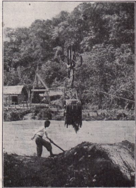
Amerikanischer Kabelbagger, von Ingenieur Vogt im Chocó (Kolumbien) aufgestellt. Kabelschaufel während der Füllung.
