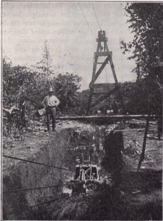
Amerikanischer Kabelbagger, von Ingenieur Vogt im Chocó (Kolumbien) aufgestellt. Kabelschaufel während der Füllung.
