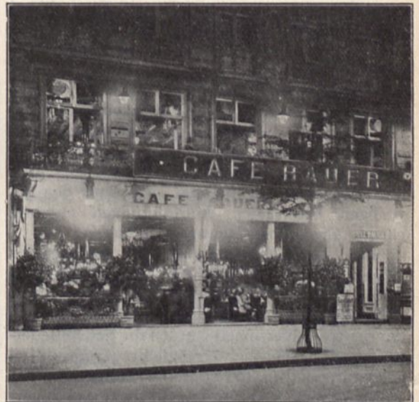
Jetzt: 4 Excello-Bogenlampen, weißes Licht, 7500 Kerzen 2,2 Kilowatt Verbrauch.
