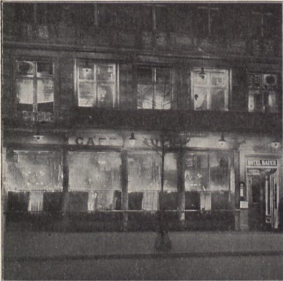
Früher: 4 Metallfadenlampen, 2400 Kerzen, 2,7 Kilowatt Verbrauch.
