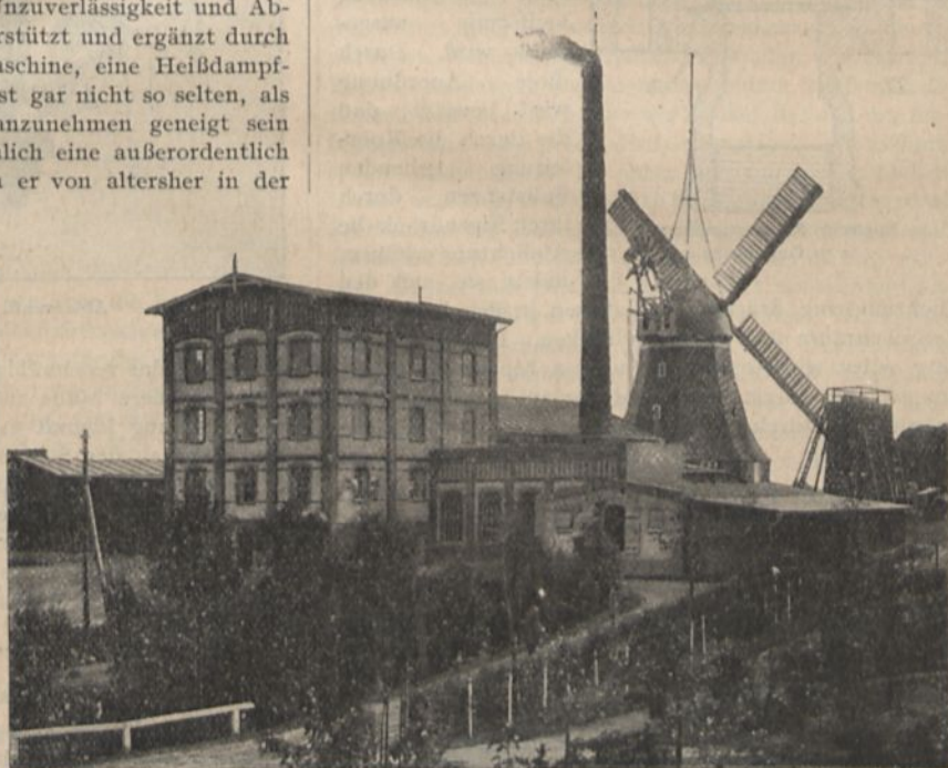
Mühle von Carl Bamberg jun. in Ribnitz mit Lanzscher Heißdampflokobile von 57—80 PS. als Aushilfskraft.
