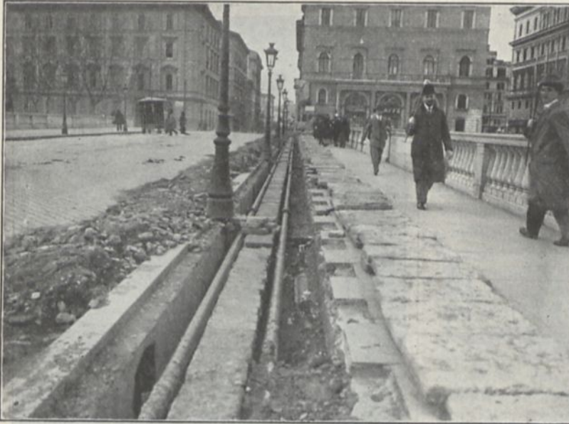
Rohrverlegung in Rom.
