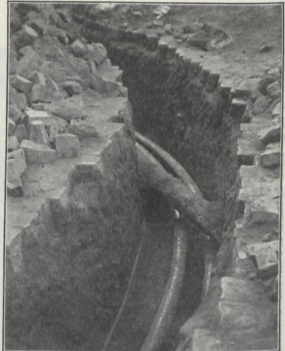
Verlegung einer Kurve unterhalb der Kanalisation.
