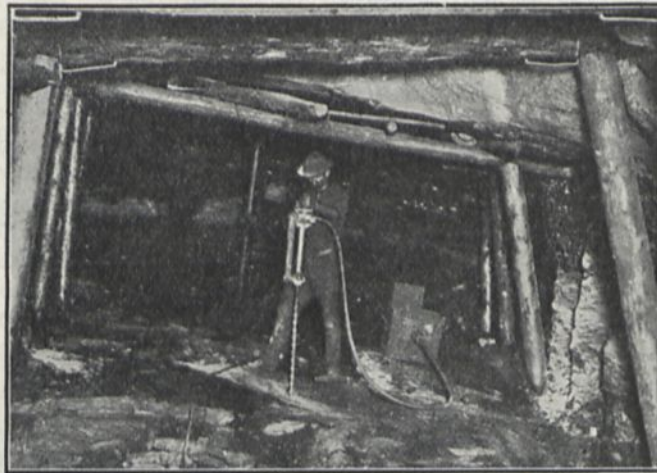
Elektrisch angetriebener Gesteinbohrhammer.
