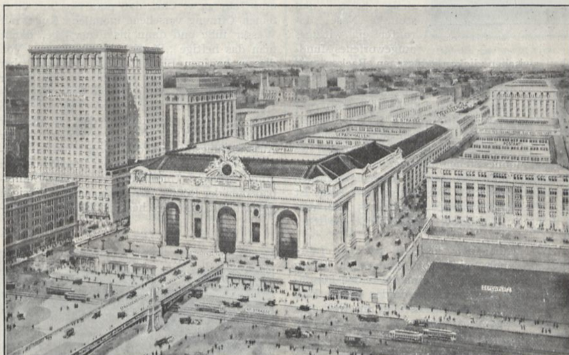
Blick aus der Vogelschau auf die Gebäude des großen Zentral-Bahnhofs in New York und die umliegenden Gebäude.
